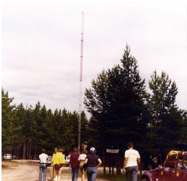
Leirin DX-asema kävi kuumana, sillä OH8QD oli pystyttänyt 37 metrin antennimaston, jonka päässä 4-el.yagi oli 20 metrin päälle käytössä!
